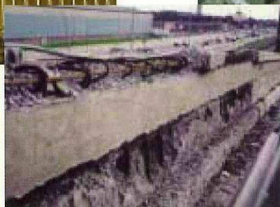
鉄筋腐食の影響
