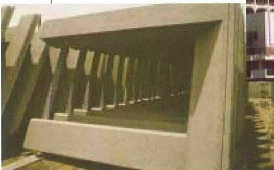
プレキャストの窓パネル
