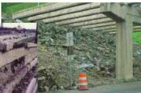
鉄筋腐食の影響
