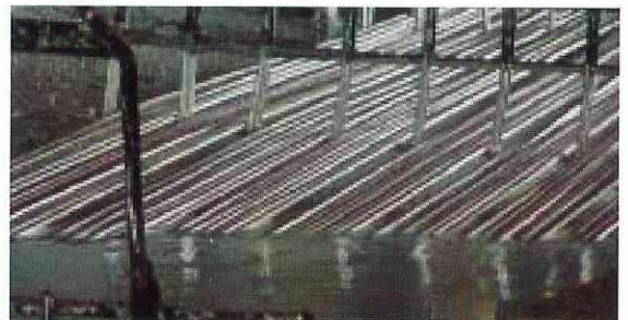
溶融亜鉛浴から引き上げられる鉄筋
