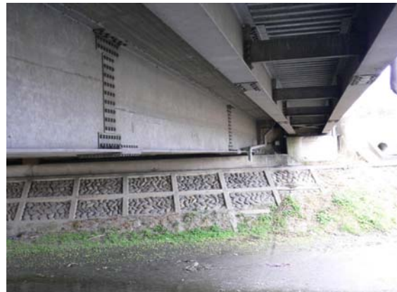
写真-2 下流側外主桁及び添接部
