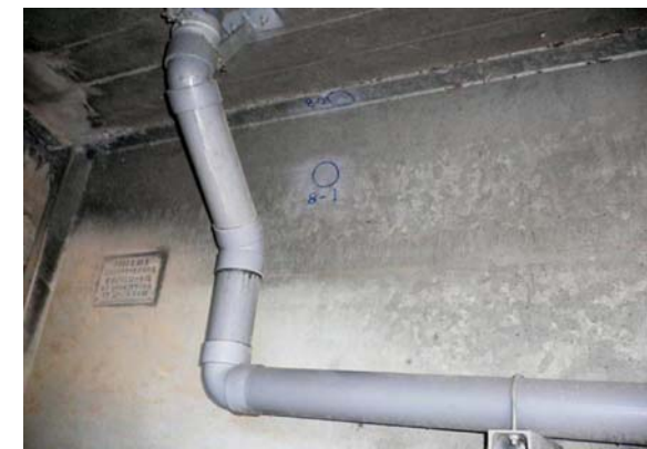
写真-3 測定点の例(下流側外主桁外側)
