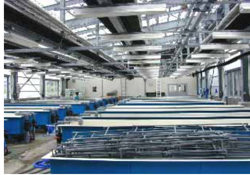
写真4 サザ工棟 H柱・梁
