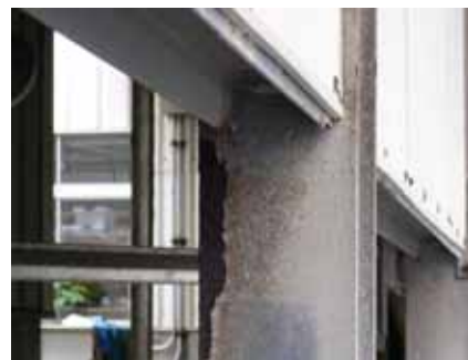
写真2 渡り廊下 柱フランジ
