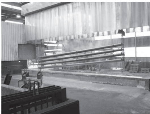
Galvamental めっき釜, 飛散防止・排気
