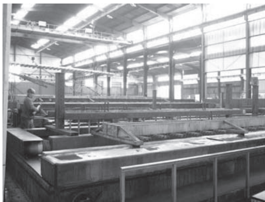
Galvamental 前処理工場, 入・排気設備
